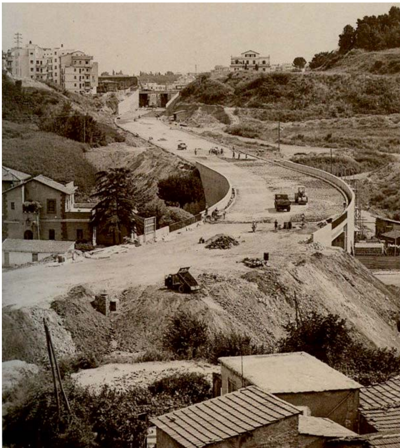
Fig. 17 – Costruzione della “Via Olimpica”, nel tratto di attraversamento della Valle dell’Inferno che prenderà il nome di Via Anastasio II (1959, foto di: C. Riccardi). - Construction of the “Olympic Avenue”, in the section crossing the which will be called Via Anastasio II (1959, C. Riccardi).
