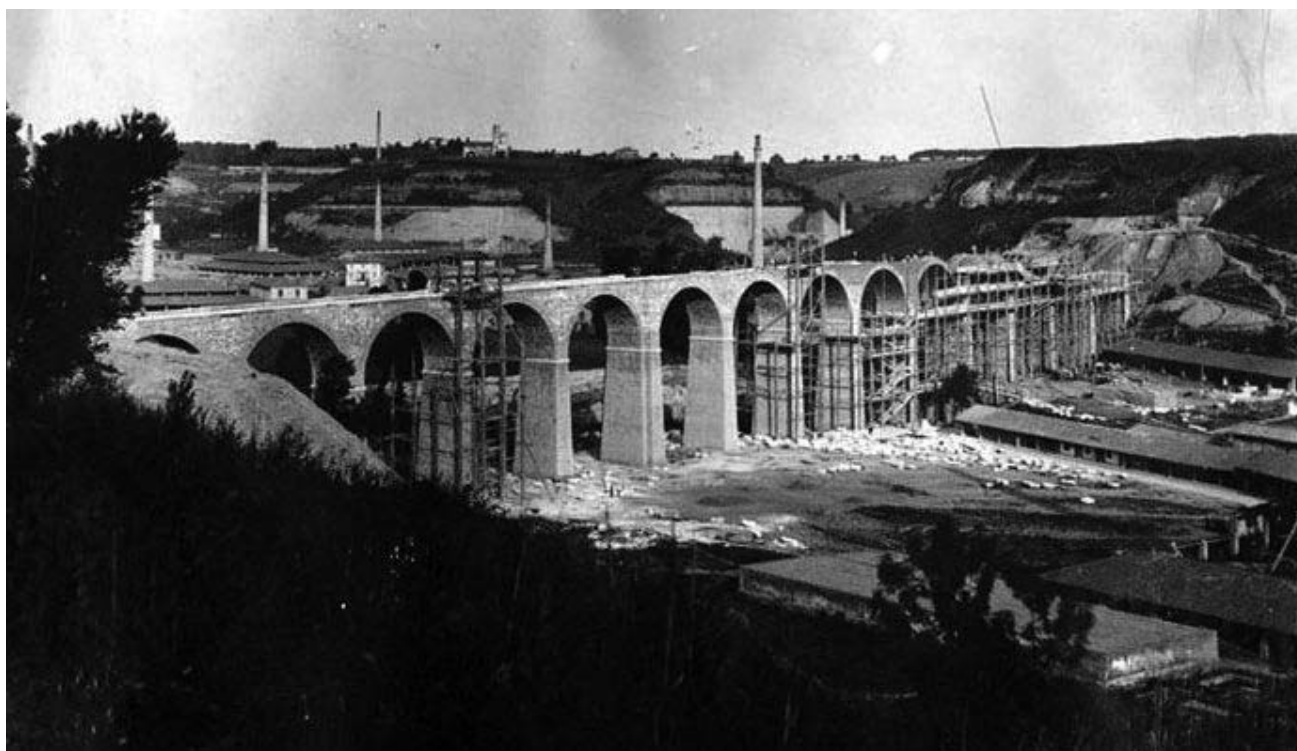
Fig. 9 – Foto della Valle dell’Inferno da Monte Vaticano. Costruzione del ponte della vecchia ferrovia Roma-Viterbo. Sullo sfondo numerose cave di argilla e fornaci (1890, foto di: L. Morpurgo, fonte: ICCD)
